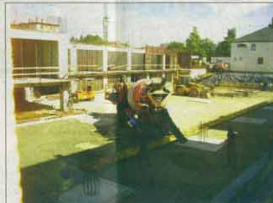
Krležina - stambeni objekt s podzemnim garažama u izgradnji
